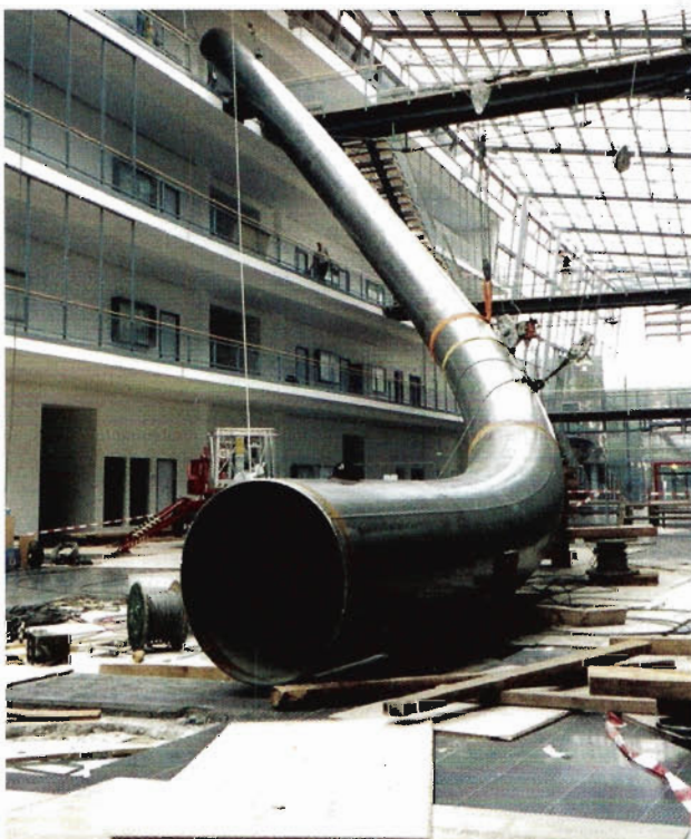
Montage eines Kunstwerkes für die Universität München, die mit Hilfe von Rollen und eines Flaschenzuges ausgesprochen präzise durchgeführt werden konnte.
